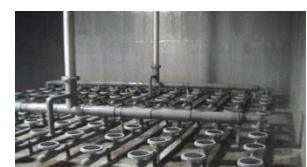
傳統細氣泡散氣盤
