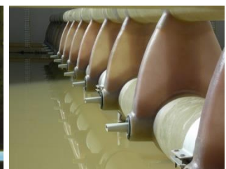
Eco-JET 噴流曝氣與氣液混合流況
